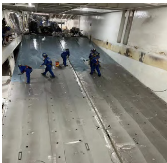
图8 底漆施工
