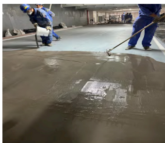
图9 防滑树脂施工
