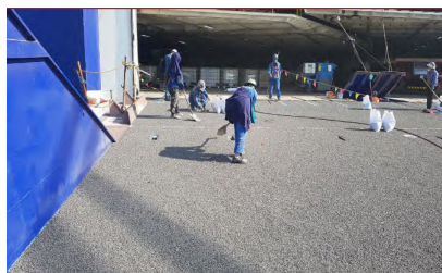
图10 防滑粒料施工
